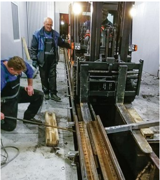
Bevor die neue Technik kommt, müssen das alte Förderband ausgebaut und das Innere modernisiert werden.
