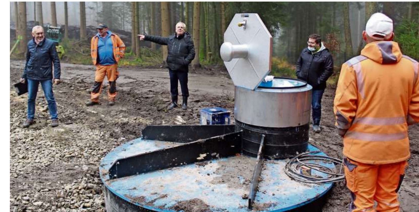
Ingenieur Dieter Albrecht, Harald Söllner von der Gemeinde Nagel, Nagels Bürgermeister Helmut Voit und Thomas Kaufmann, Bürgermeister von Immenreuth (von links), begutachteten die Sanierungen im Quellgebiet „Neuwelt“, darunter auch eine der neuen Brunnenstuben. Foto: Christian Schilling
