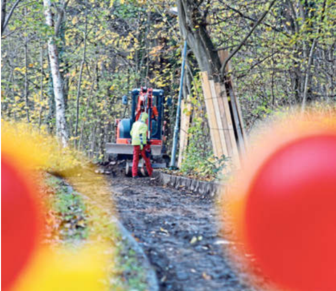
Arbeiter der Firma Schneider aus Kirchlingern haben die Pflasterung bereits teilweise herausgehoben.
