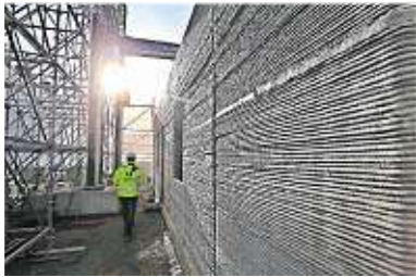
Bauarbeiter bauen das Haus in drei Wochen mit dem 3D-Drucker. FOTO: DPA
