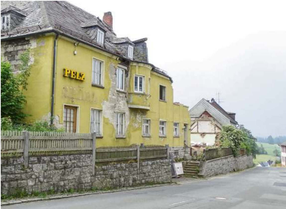
Die Gebäude des Unternehmens Pelu-Spörl in Schwarzenbach am Wald, die lange leer gestanden hatten, wurden vor zwei Jahren abgerissen. Jetzt entsteht hier eine grüne Oase mit Zugang zum Friedhof der Stadt und zum Philipp-Wolfrum-Haus.
