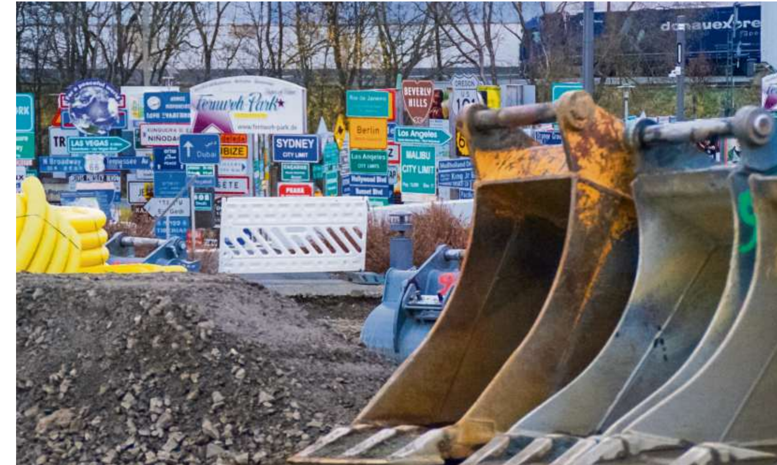
Östlich des Summa- und des Fernweharks wird kräftig gebuddelt: Hier ist die Erschließung des neuen Wohngebiets „Schwesnitzalblick“ im vollen Gange. In der Nachbarschaft soll auf dem bisherigen „Sondergebiet Hotel“ die „ökologische Mehrgenerationensiedlung“ entstehen.
