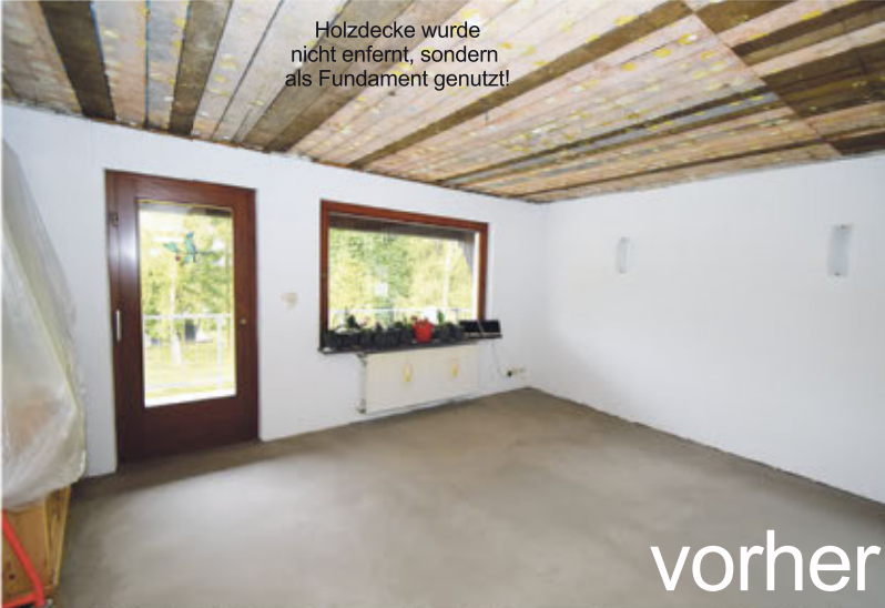
Vorher: Holzdecke im Wohnzimmer nach der Entfernung der Styroporplatten. Vor dem Einbau der Spanndecke wurde eine Dampfsperre vom Dachdecker montiert.
