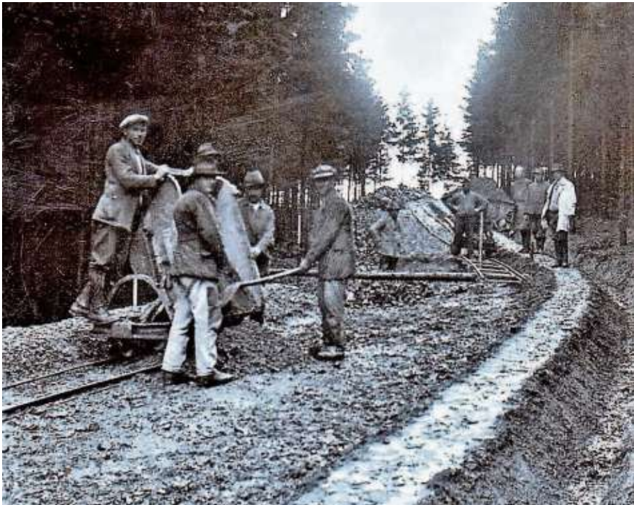
Beim Bau der Traindorfer Straße von Stockheim nach Traindorf verdienten die Arbeiter am Tag drei Reichsmark.
