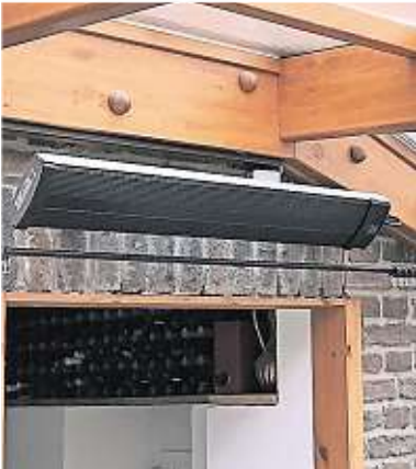
Acht dieser Dunkelstrahler werden in der Kirche installiert. FOTO: REDTHERM
