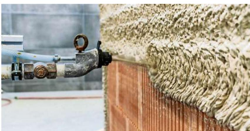
Mit dem Produkt „Spritzbare Fassadendämmung mit Glass Bubbles“ ist Maxit für den Preis nominiert.
