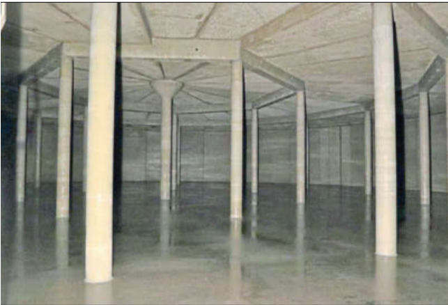
In den Behälterkammern des neuen Wasserspeichers tragen Säulen die Decke. Foto: Dirk Windmüller
