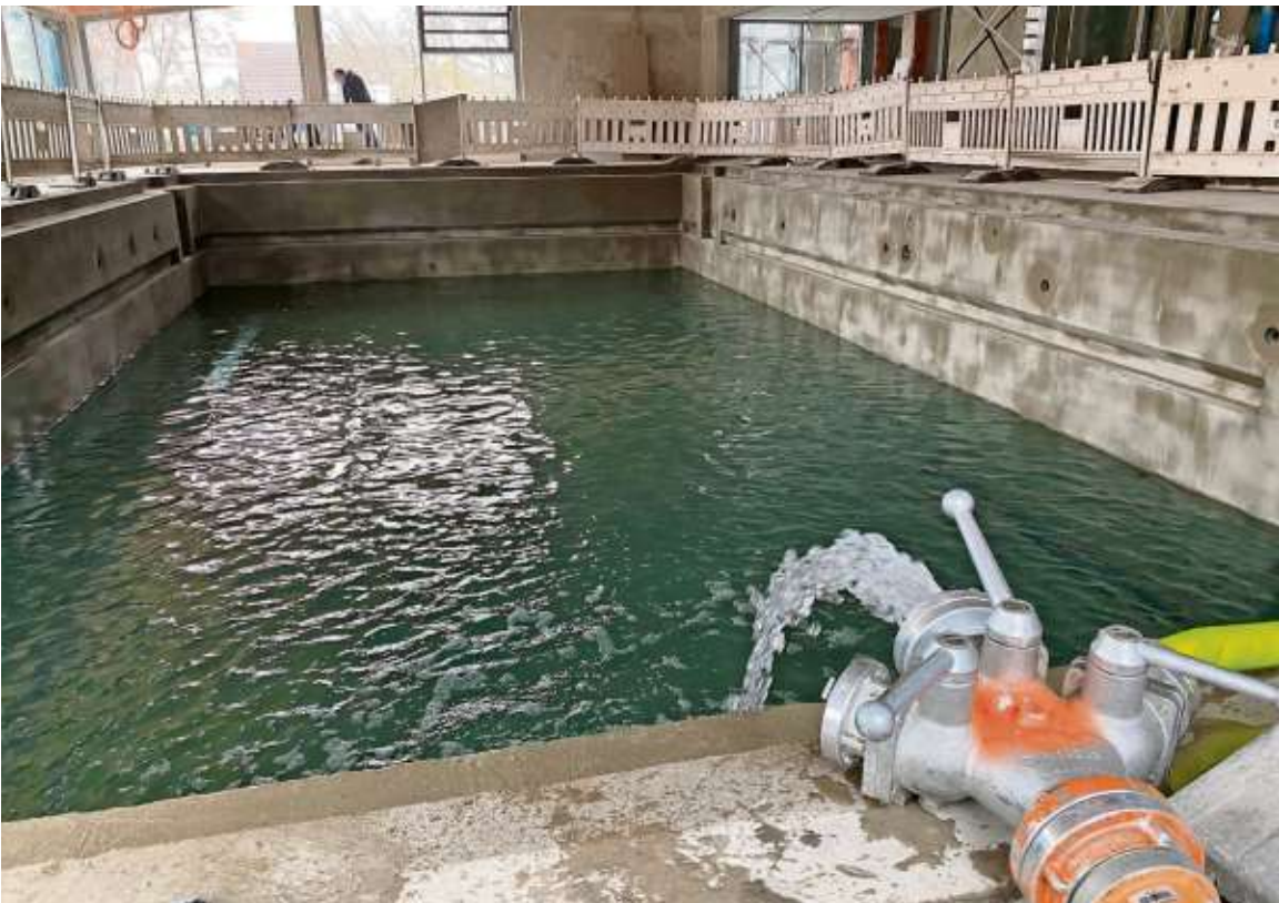
Mit dem dicken Feuerwehrschauch wird das Becken für die Dichtigkeitsprüfung mit Wasser gefüllt.
