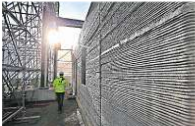
Bauarbeiter bauen das Haus in drei Wochen mit dem 3D-Drucker. FOTO: DPA
