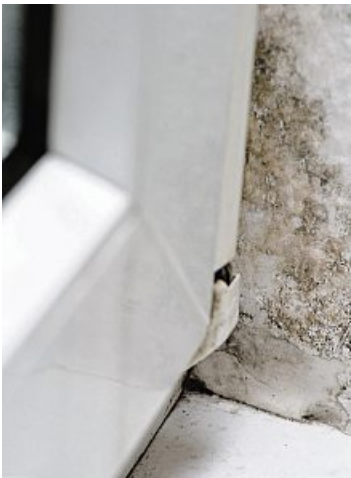
Der schwarze Belag an der Wand ist gefährlicher Schimmel. Vorbeugend hilft regelmäßiges Lüften.
