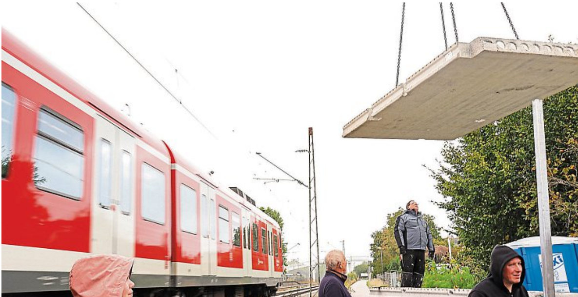
Das Bauunternehmen Dennert Massivhaus errichtete mit tonnenschweren Fertigbauelementen aus Beton direkt an den Bahngleisen in Pulling bei Freising ein Einfamilienhaus.
