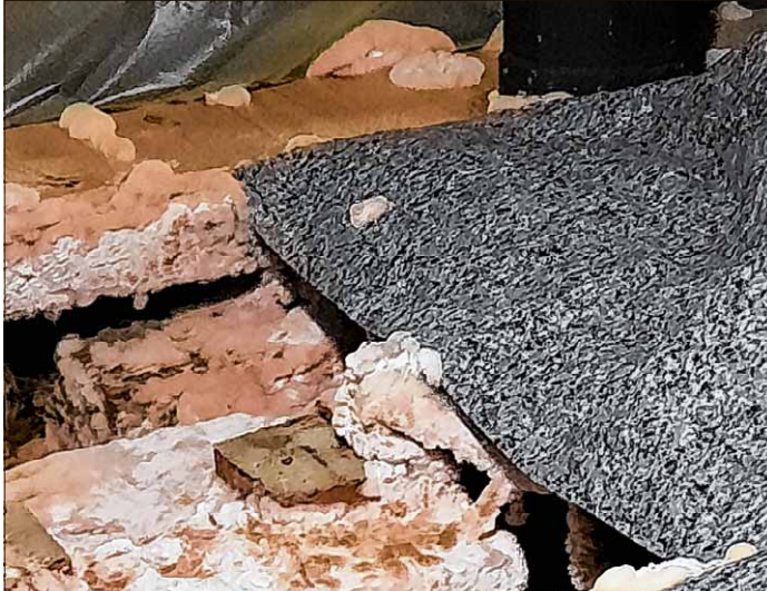
Ein Bild vom eingehausten Bereich. Der Schwamm hat sogar schon die Folie in Besitz genommen. Fotos: Klaus-Dieter Steuer
