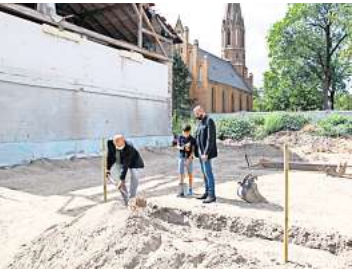
Im Sommer ist der Grundstein für das Seniorenhaus in Lietzow gelegt worden. FOTO: ANDREAS KAATZ
