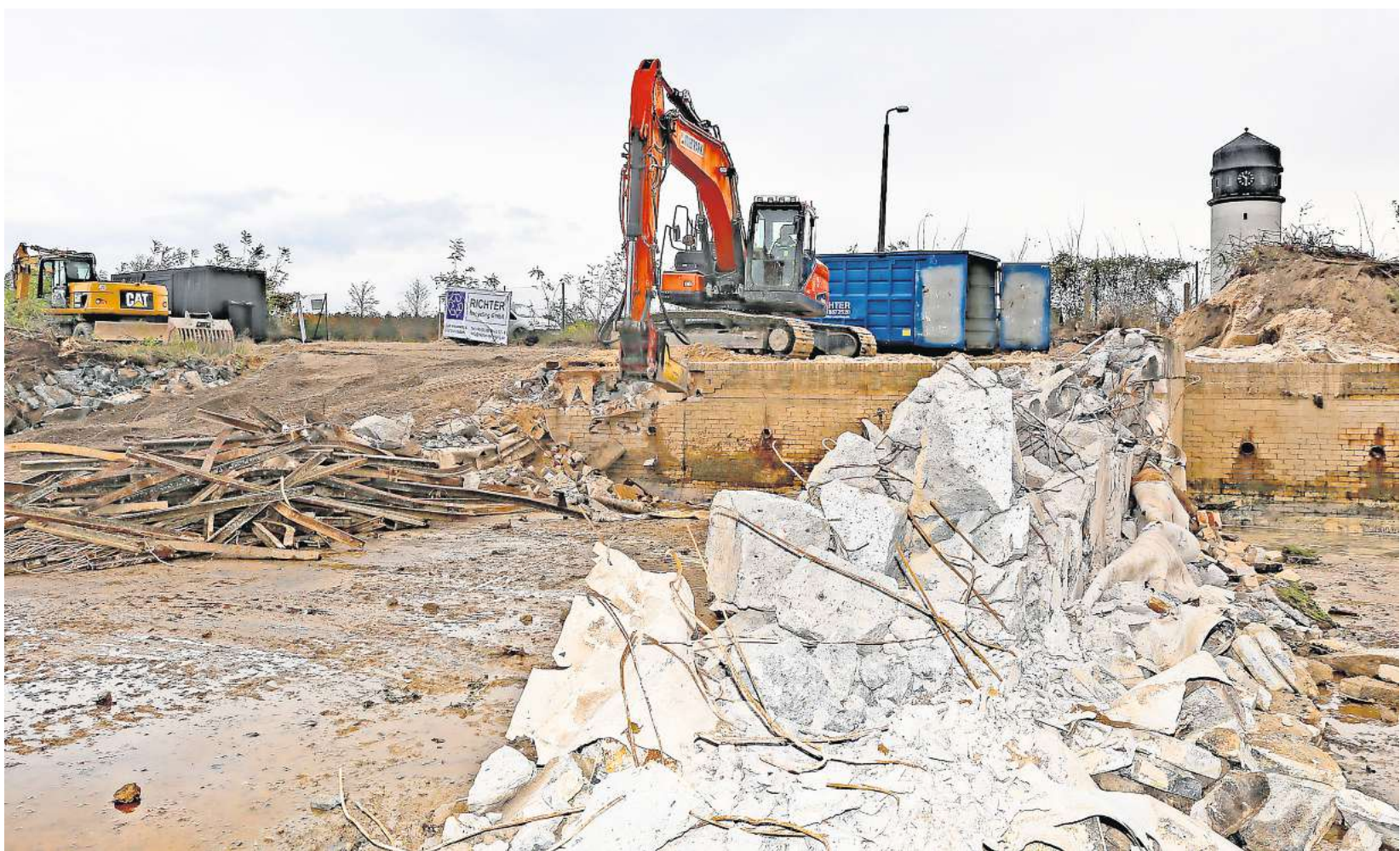
Als erster Schritt sollen die alten Absetzbecken demontiert und in der Grube neuer Erdboden aufgefüllt werden.
