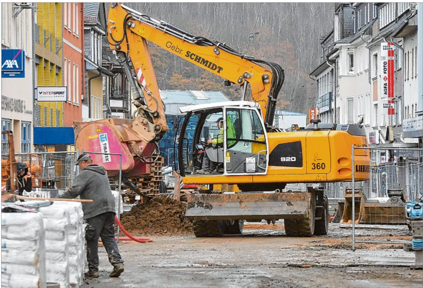
Der Ausbau der Rathausstraße bleibt ein Zankapfel in Wissen. Während dort gebaggert wird, arbeitet die BI im Hintergrund.
