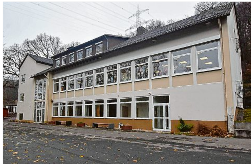
In erster Linie soll der Altbau, rechts im Bild, angepackt werden.
