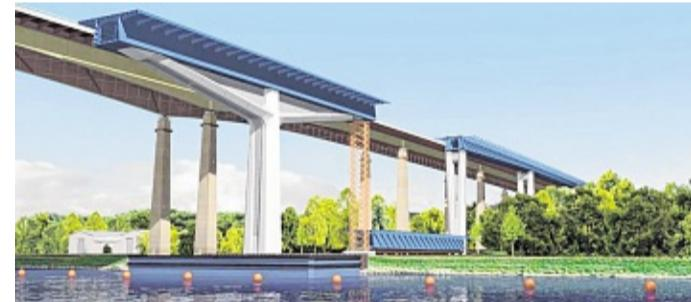
Die Träger der Fahrbahn sollen auf dem Wasserweg angeliefert und hydraulisch in die Höhe befördert werden. ILLUSTRATIONEN: DEGES
