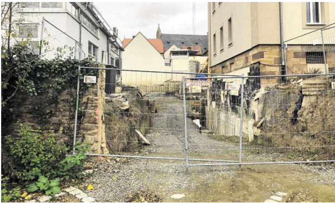
An der künftigen Einfahrt zur Tiefgarage wurde inzwischen das Fundament der Grabenschule (rechts) mit Beton unterstützt.
