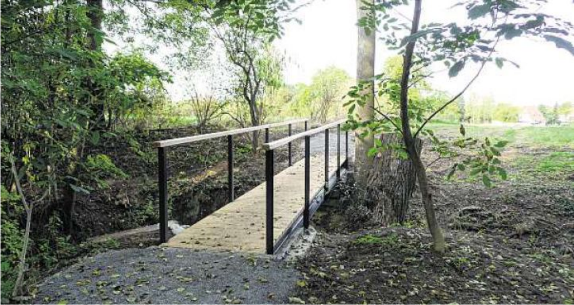
Die neue Brücke über die Volkach ist nun geöffnet.
