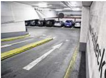
Das Parkhaus Graben in der Schweinfurter Innenstadt ist ab Januar geschlossen und wird bis November 2021 saniert. FOTO: OLIVER SCHIKORA
