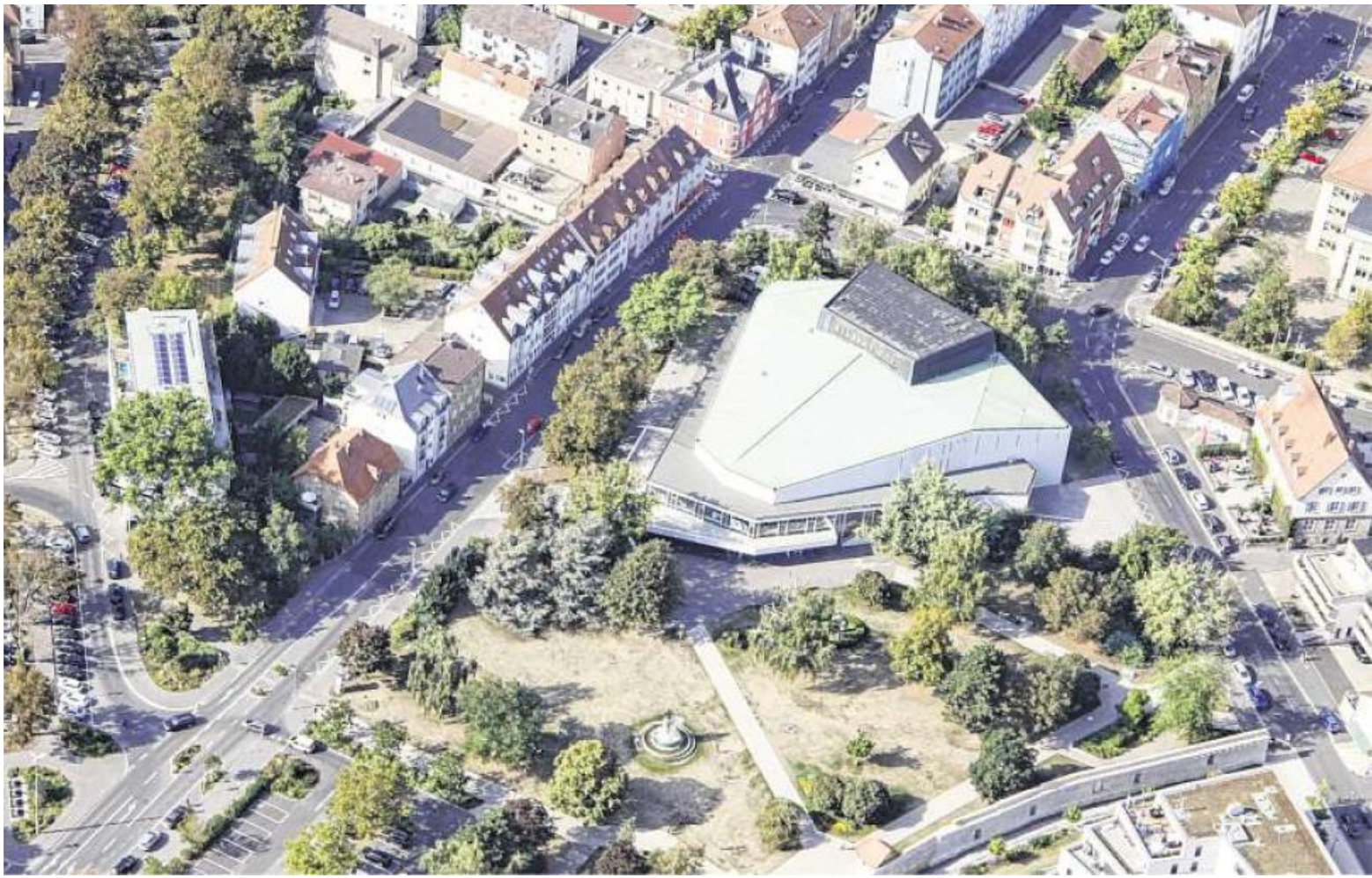
Das markante Dach des Schweinfurter Theaters ist aus Kupfer, es muss neben der Haus- und Bühnentechnik vollständig saniert werden.
