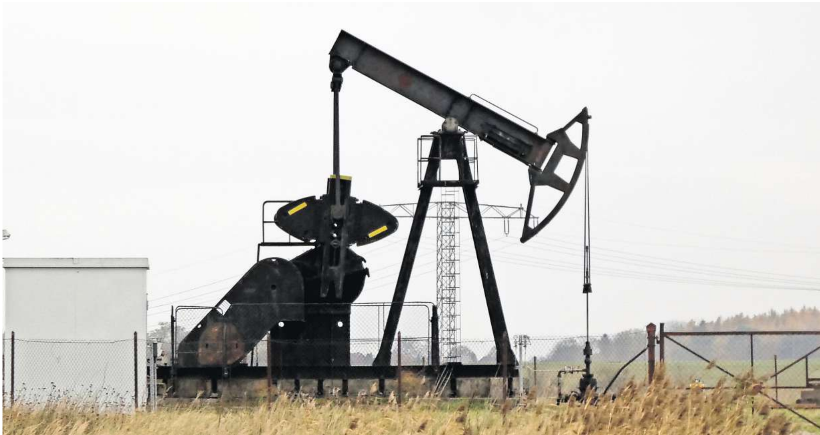
Die Förderstelle Mesekenhagen I (Kowall) soll modernisiert werden.
