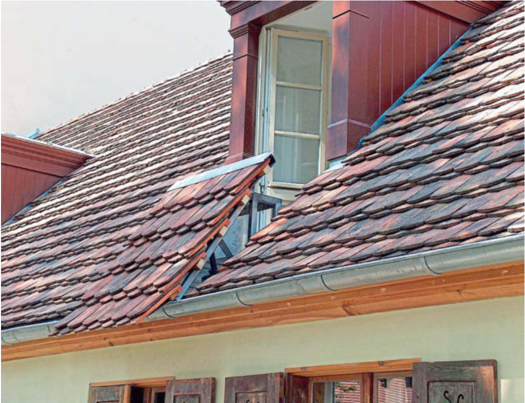
Fluchtweggaube: Bei diesem System lassen sich zwei in Trittstellung gebrachte Stufen über die Traufe hinweg nach außen klappen, sodass sie eine geeignete Rettungsfläche für die Feuerwehr bieten.
