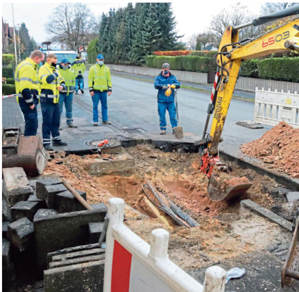
Um den Fehler am Stromkabel zu suchen, wird das Erdreich an der Detmolder Straße aufgegraben. Dabei entdecken die Bauarbeiter, dass hier auch Gas aus der Hauptleitung austritt. FOTO: KNUT DINTER
