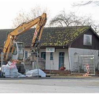
Brandruine an der B 199 in Kappeln. In dieser Woche begannen die Abrissarbeiten.
