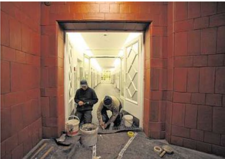
Im Moment wird an vielen Stellen im Gebäude noch gearbeitet.
