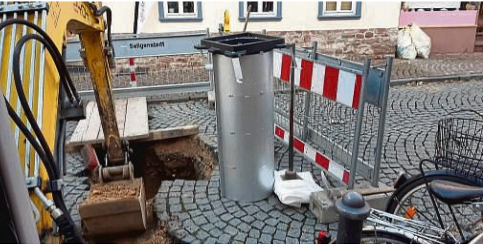
Poller-Baustelle: Der versenkbare Pfosten wird per Code gesteuert.
