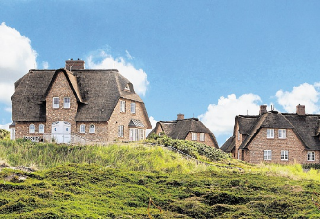
Viel Dauerwohnraum auf Sylt wird in absehbarer Zeit in Ferienwohnungen umgewandelt. FOTO: DPA
