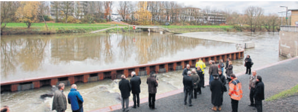
2010: Der Fischaufstieg am Stadtwerke-Wehr wird eröffnet. Die knapp 1,4 Millionen Euro Kosten hat im Wesentlichen die Deutsche Bahn AG bezahlt – als Ausgleichsmaßnahme für den Bau der ICE-Strecke Frankfurt-Köln.
