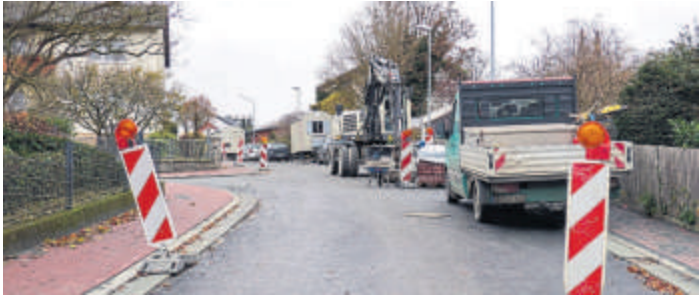
Die Straße Schöne Aussicht ist nach der grundhaften Erneuerung weitestgehend fertiggestellt.
