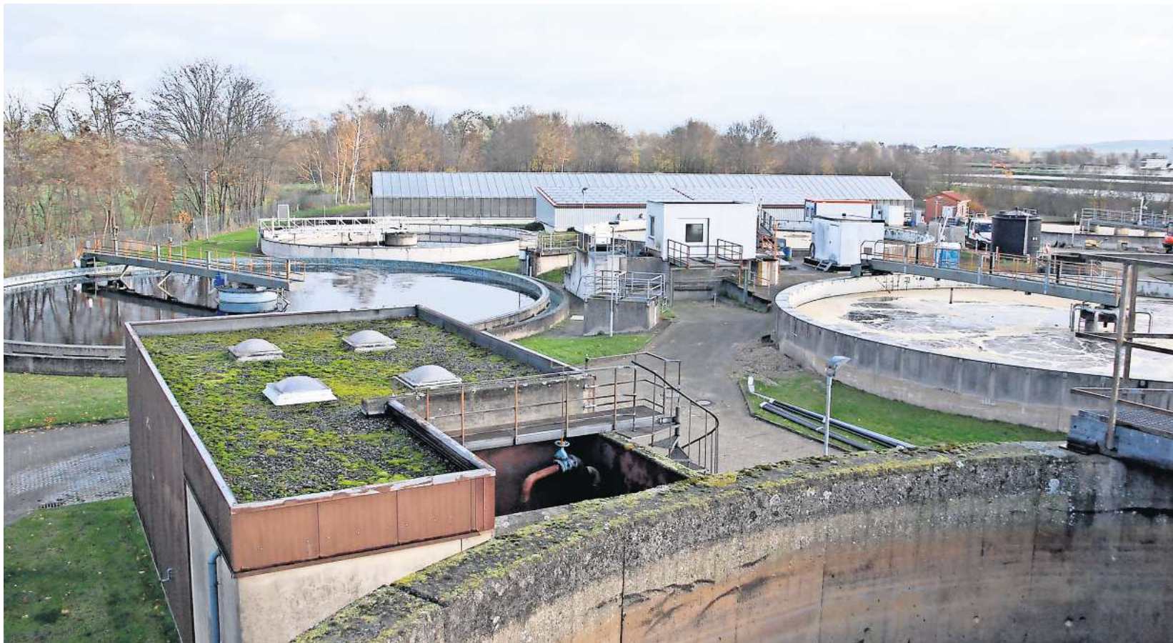
In der Nordstemmer Kläranlage soll die alte Schlammmentwässerungsanlage (vorn links) erneuert werden.
