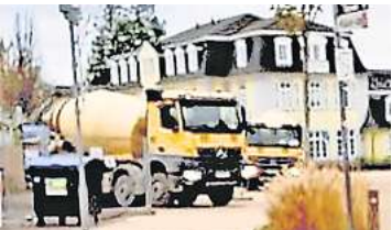
Die Betonmischer sind derzeit vor dem Kurhaus im Dauereinsatz.
