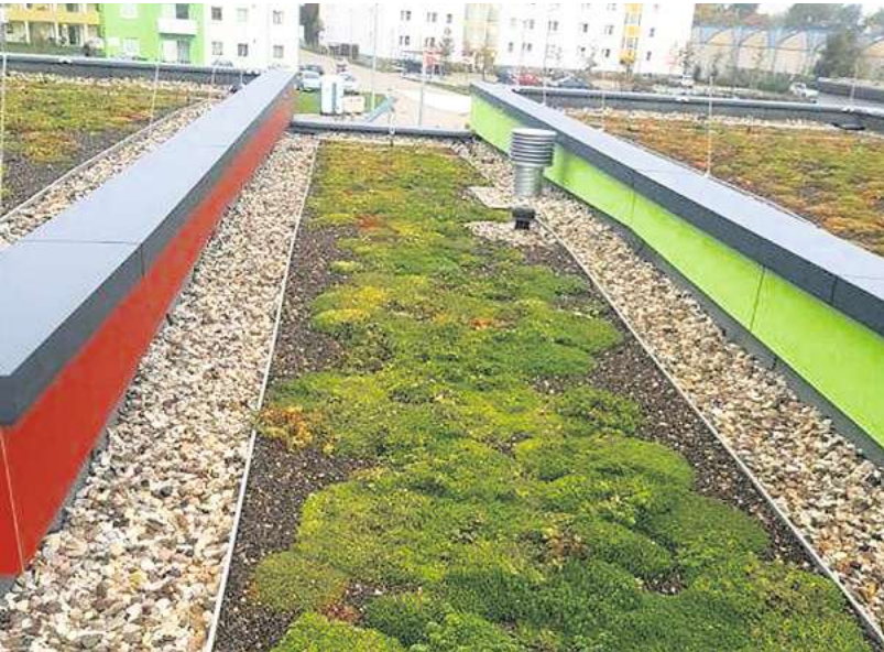
Auch das Dach der neuen Kita Seegrasweg in Empelde ist begrünt. FOTO: PRIVAT
