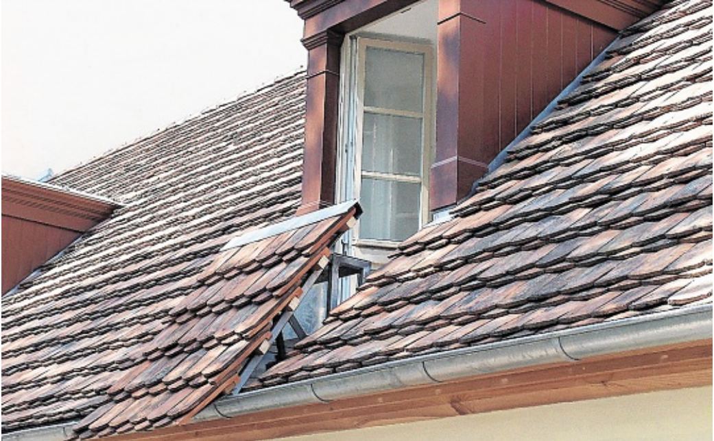
Fluchtweggaube: Bei diesem System lassen sich zwei Stufen über die Traufe hinweg nach außen klappen, sodass sie eine geeignete Rettungsfläche für die Feuerwehr bieten. FOTO: SOLTKAHN
