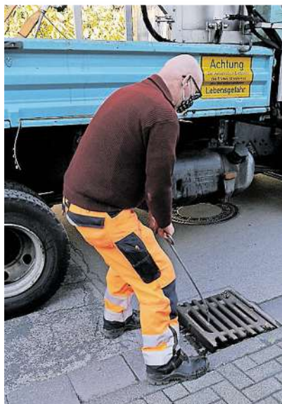
Rolf Naeven hebt den Gullydeckel hoch und zieht ihn zur Seite, bevor er den Schlammeimer mithilfe eines kleinen Krans herauszieht. Wie bei Müllfahrzeugen wird der Eimer dann entleert.
