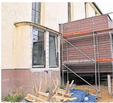
So sehen die Anbauten für die Gruppenräume von außen aus. FOTOS: KINKEL
