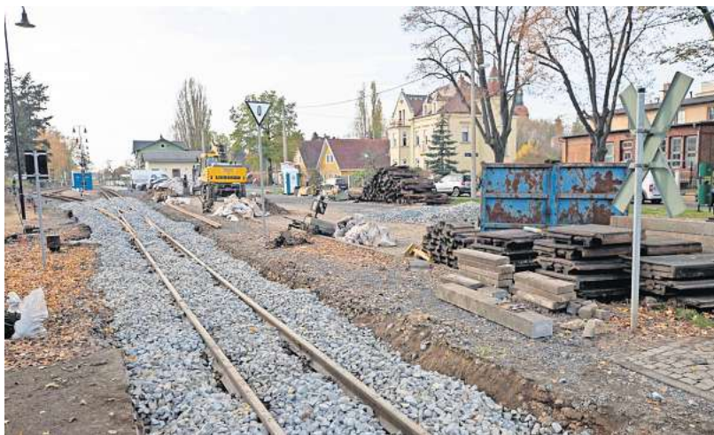
Am Moritzburger Nadelöhr der Schmalspurbahn wurde Schienen und Weichen erneuert.
