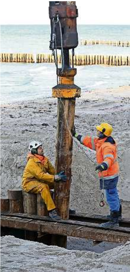
Arbeiter und ein Bagger ersetzen die kaputten Kiefernholz-Stämme. FOTO: WÜSTNECK/DPA-ZENTRALBILD/ZB
