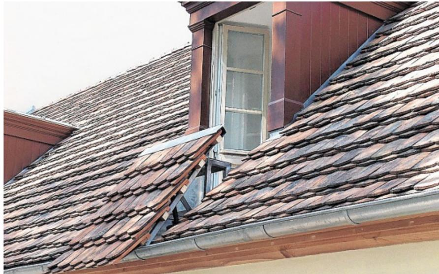
**Fluchtweggaube:** Bei diesem System lassen sich zwei Stufen über die Traufe hinweg nach außen klappen, sodass sie eine geeignete Rettungsfläche für die Feuerwehr bieten. FOTO: SOLTKAHN
