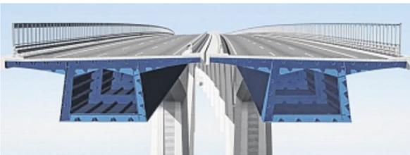
Die neue Rader Hochbrücke wird aus zwei einzelnen Brücken mit jeweils drei Fahrspuren bestehen.
