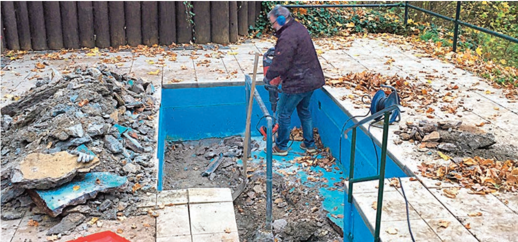
Mit dem Abbruchhammer wurde der Boden komplett herausgemeißelt, der Schutt wurde auf vier Anhängerladungen verteilt.
