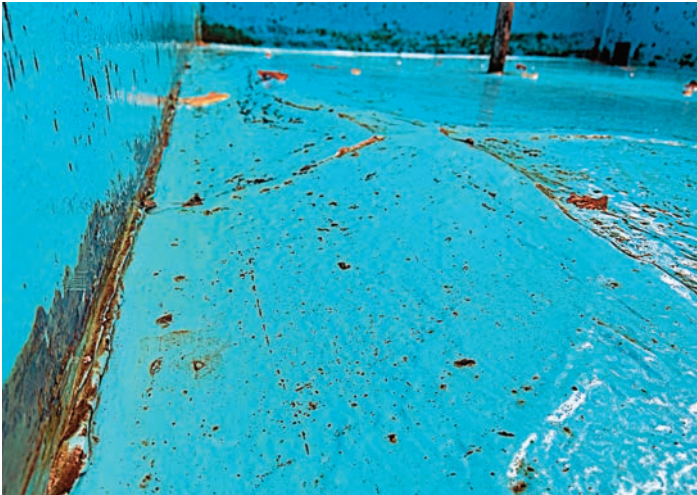
Der Boden des Tretbeckens wurde bereits hochgedrückt, auch einige Risse und verschobene Bodenplatten waren vorhanden.
