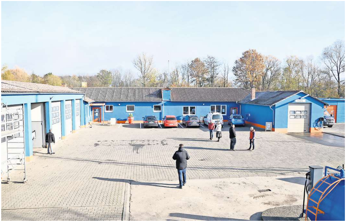
Der Servicehof von Ebsdorfergrund ist nach zweijähriger Sanierungsphase fertiggestellt.
