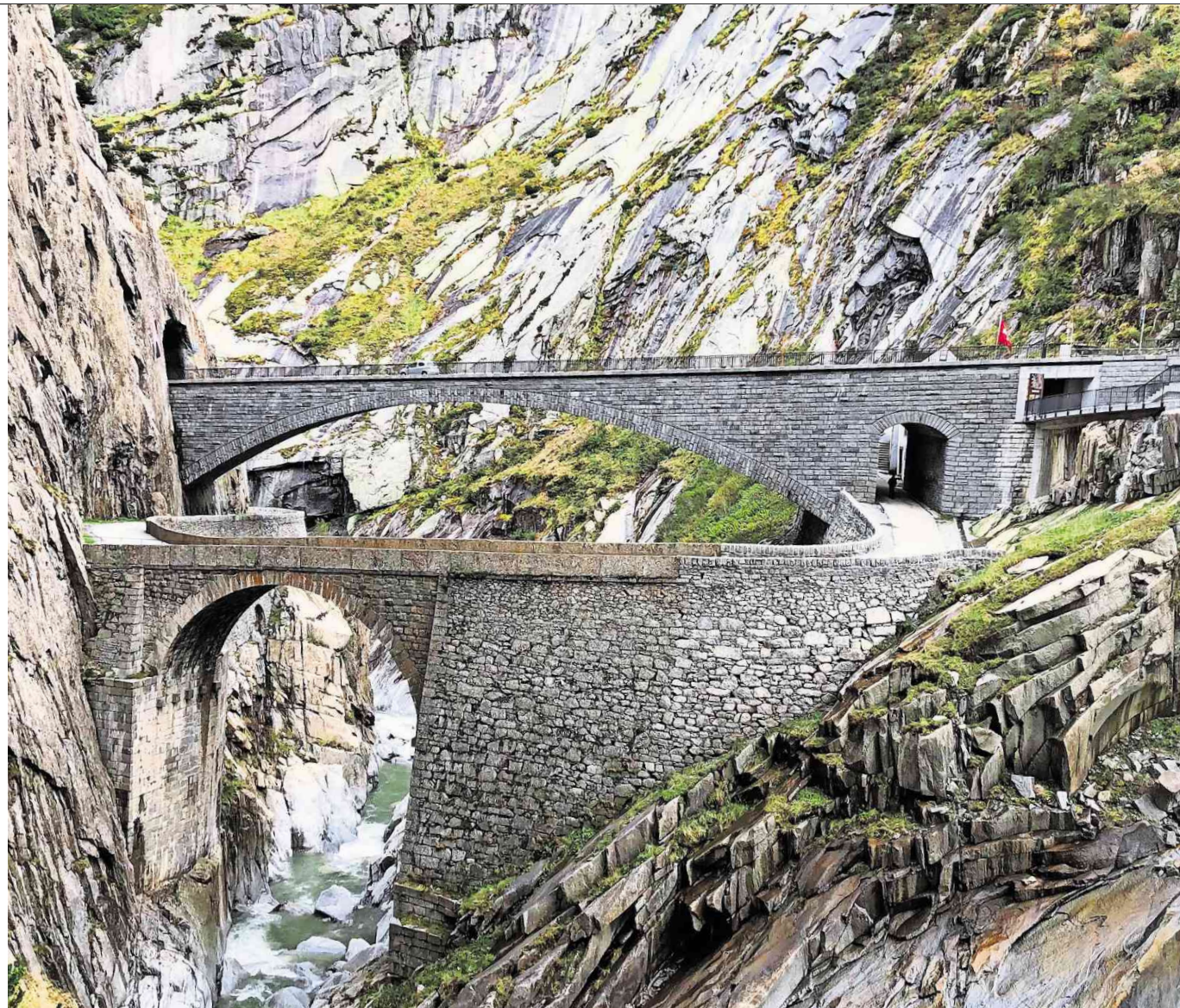
Tyyfelsbrigg - Teufelsbrücke - heißt dieses Bauwerk bei Andermatt. Fotos: Wolfgang Molitor
