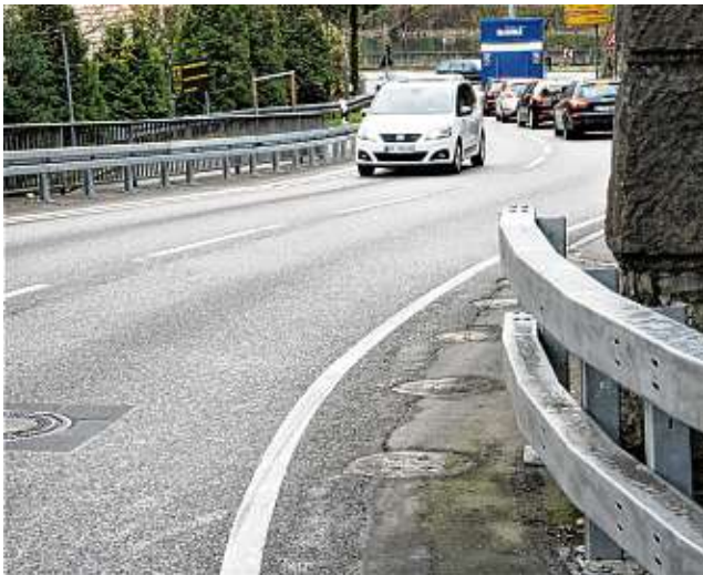
An der Abfahrt Hauenstein ist die Fahrbahn verbreitert worden. Links neben den neuen Leitplanken sind die Befestigungspunkte der alten zu sehen. BILD: REINHARD HERBRIG
