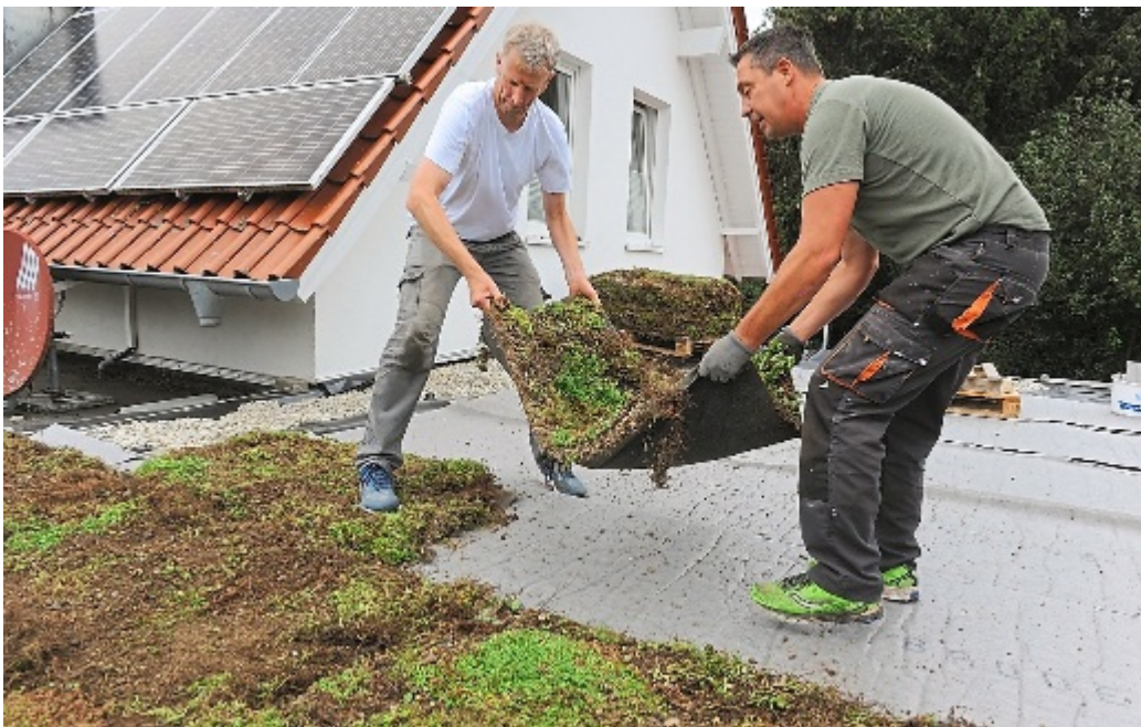
Mit seinem Freund Ralf Kulik (r.) trägt Kay Schneidewind (l.) die fertigen Matten auf das zuvor mit Folie präparierte Garagendach.
