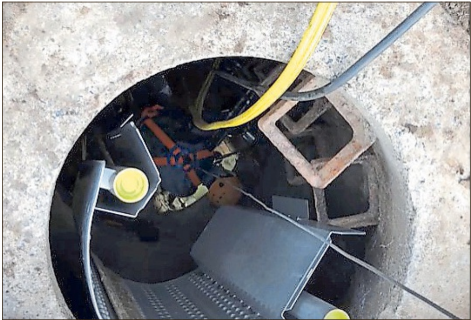
Ein solcher Kanalwärmetauscher könnte für die Energieerzeugung im Otto-Quartier zum Einsatz kommen. Foto: GASAG Solution Plus
