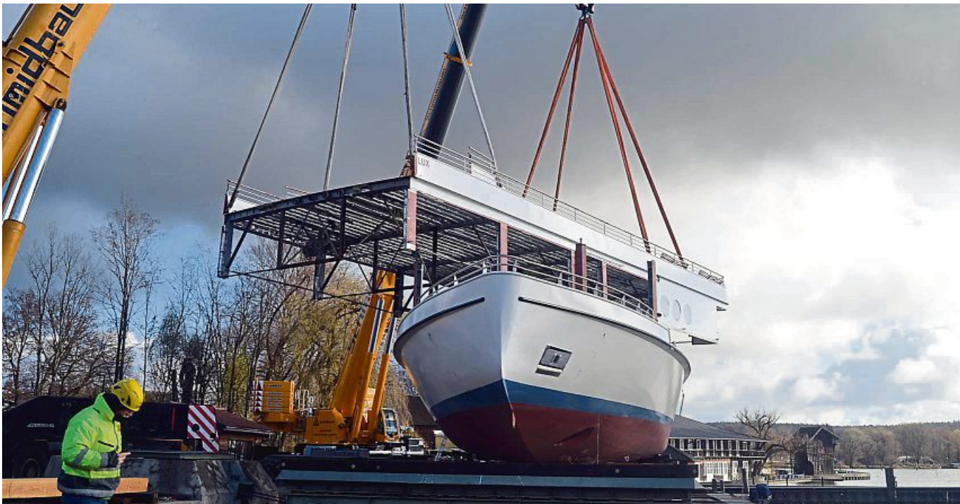
Mit einem großen Autokran wird das Oberdeck auf den Rumpf des Elektro-Schiffes gehoben.
