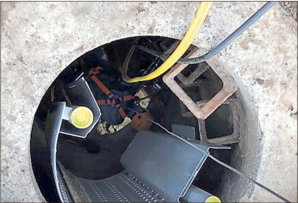
Ein solcher Kanalwärmetauscher könnte für die Energieerzeugung im Otto-Quartier zum Einsatz kommen.
