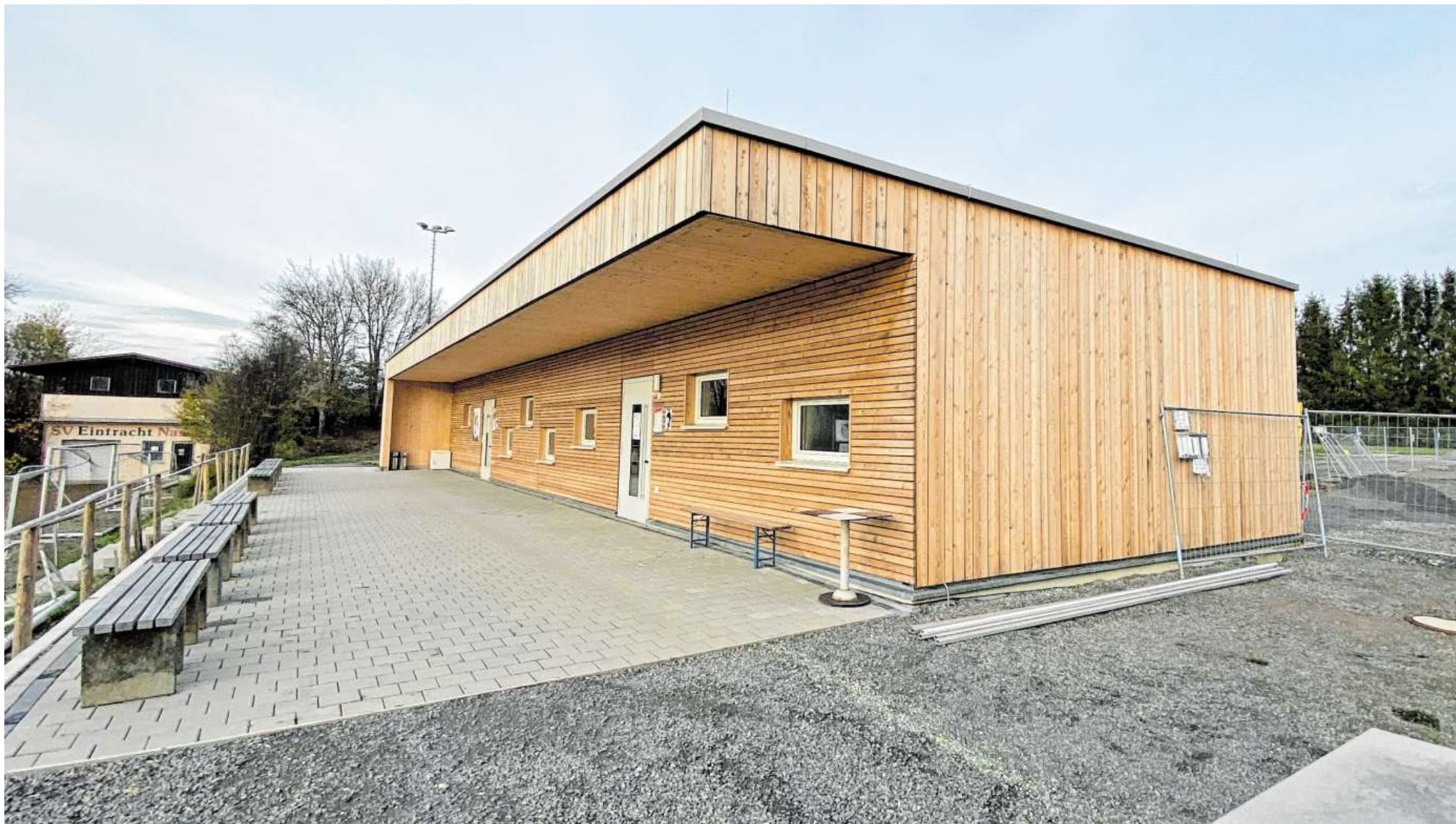
Vor allem die allgemeine Preissteigerung sorgte für Mehrkosten beim Bau des Duschtrakts am Nassiger Sportplatz. Dazu kamen nicht vorgesehene Kosten für die Entwässerung.
