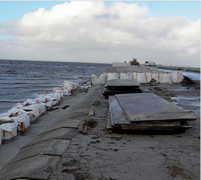
Ein deutliches Mehr an Sicherheit: Das neue Deckwerk (hinten) ist wesentlich massiver als das alte (vorn).
