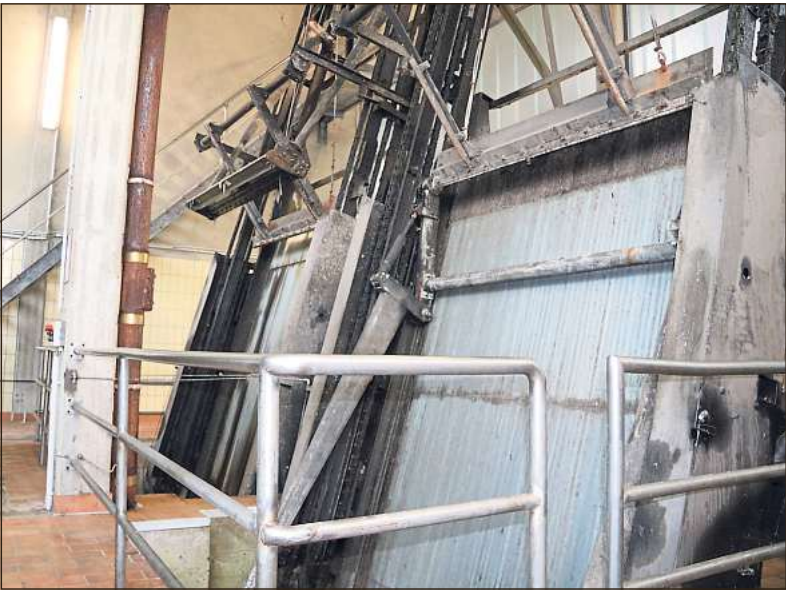
Die beiden Grobrechen der Kläranlage: Mit der Modernisierung werden sie nicht mehr benötigt.
