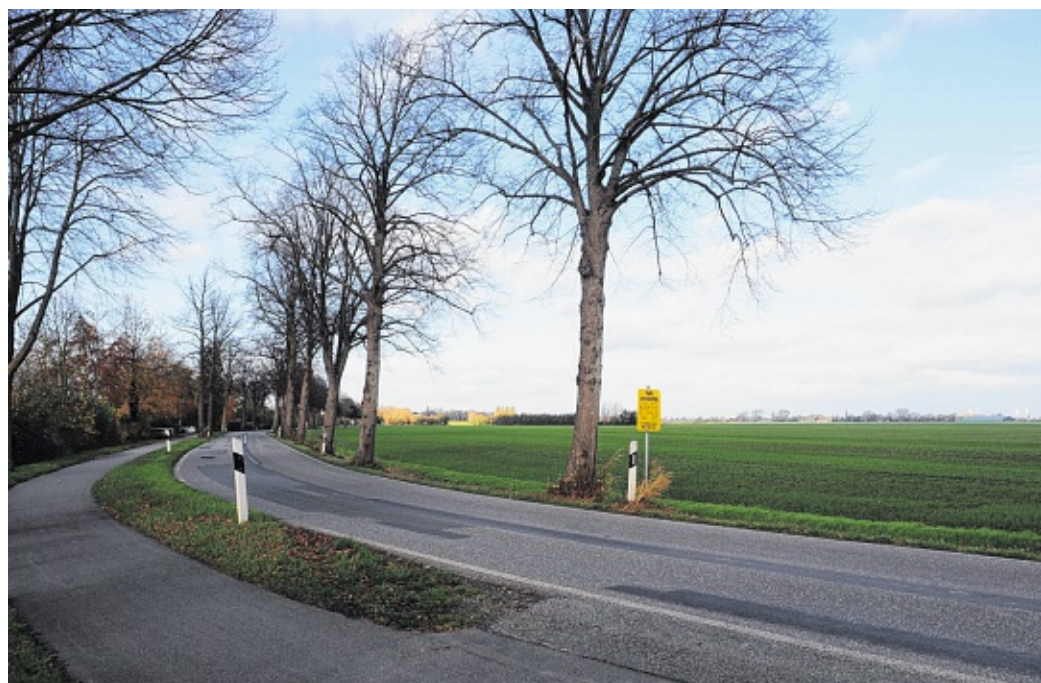
Die Kreisstraße 19 soll grundsaniert werden.
