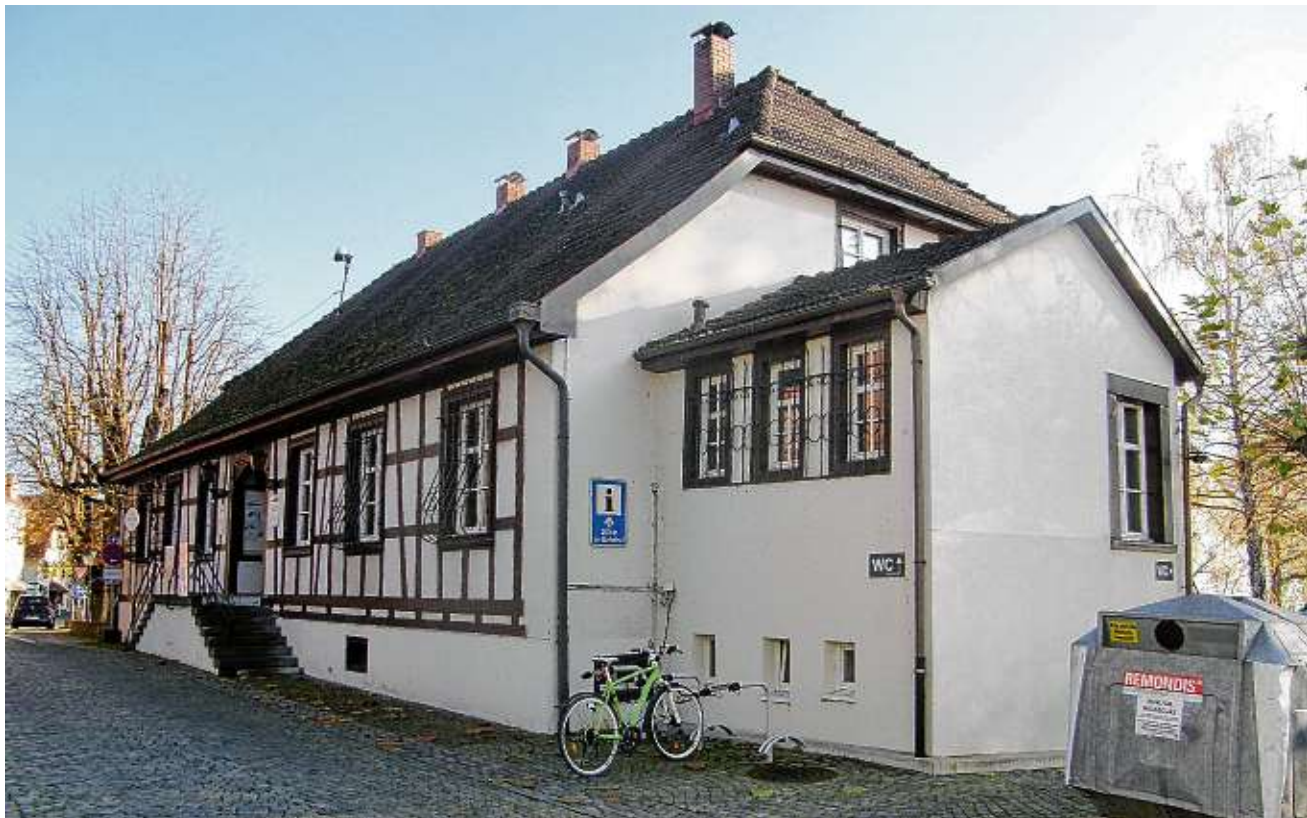
Das Gebäude am Rathausplatz 2 will die Gemeinde Allensbach in den kommenden Jahren weiter sanieren. 2021 geht es um die Torkel (am hinteren Giebel) und den Anbau eines Lifts am Westgiebel (vorn). BILD: THOMAS ZOCH
