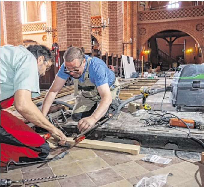
Nach den umfangreichen Sanierungsarbeiten im Innern ist nun das Umfeld der St. Georgenkirche an der Reihe. FOTO: THOMAS ZENKER
