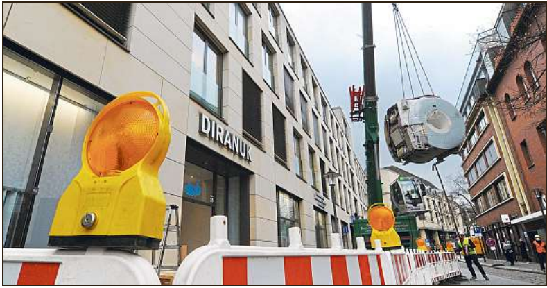
5,8 Tonnen Gewicht hat der Autokran am Haken, als das neue MRT-Gerät langsam vom Transporter auf den Gehweg vor der Diranuk-Praxis an der Welle einschwebt. Bild: Bernhard Pierel
