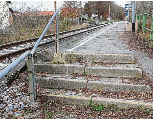
Der alte Bahnsteig am Bahnhof-Nord Richtung Weilheim wird komplett zurückgebaut. An seiner Stelle soll ein Fußweg entstehen. Der Bahnsteig auf der anderen Gleisseite Richtung Schongau wird erneuert.
