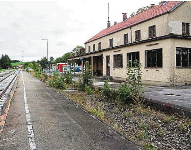
Auch am Bahnhof-Ost rücken im kommenden Jahr die Bagger an. Mit dem barrierefreien Ausbau sind auch die Tage des alten Stellwerks im gemeindeeigenen Bahnhofsgebäude gezählt.
