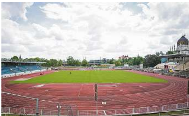
Die Tribüne links wurde von 2015 bis 2017 erneuert – nun soll die Sanierung im Heinz-Steyer-Stadion weitergehen.
