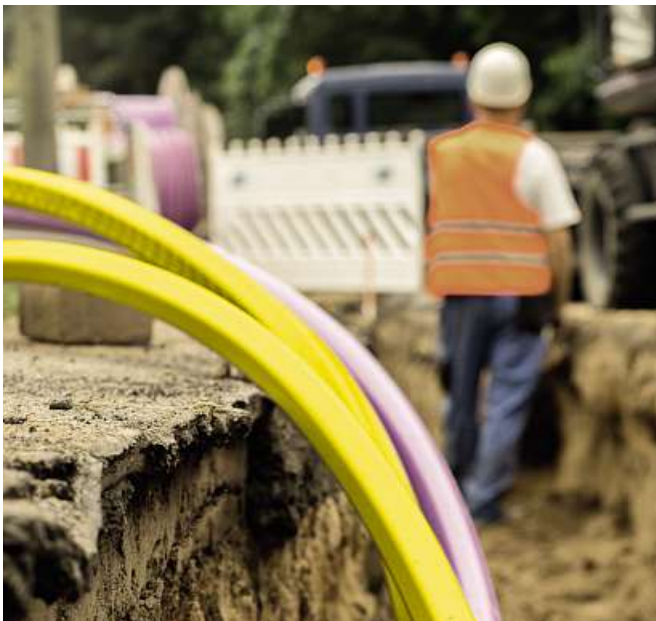
EWE und Glasfaser Nordwest bauen aus. Glasfaser für Achim.
